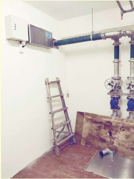
大樓污水機房除臭
